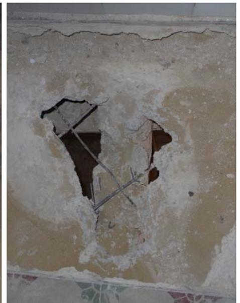
En la cata de positivos la viga tiene 2 $\phi$ 28 de acero liso y un recubrimiento inferior de 2 cm.
