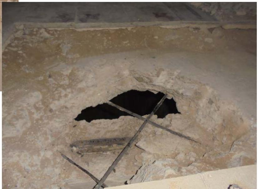
En la zona de positivos la viga tiene 2 $\phi$  de acero liso, se supone que el diámetro del acero es de 28 mm debido a la corrosión que presenta las mismas no se puede definir el diámetro de manera exacta.
