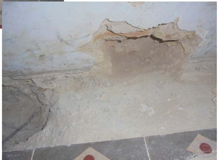
En la cata de positivos la viga tiene 2 $\phi$ 28 de acero liso y un recubrimiento inferior de 3 cm. Se detecta un gancho que une una de las dos armaduras de la viga a la armadura de la losa.
