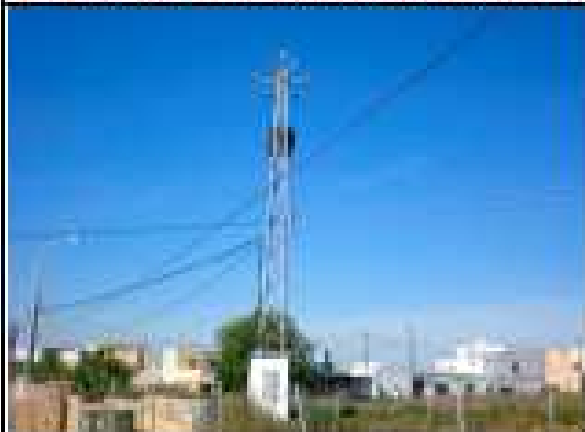
Torres de fibra a demoler.
