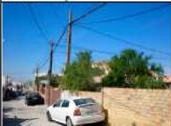
Torres de fibra a demoler.
